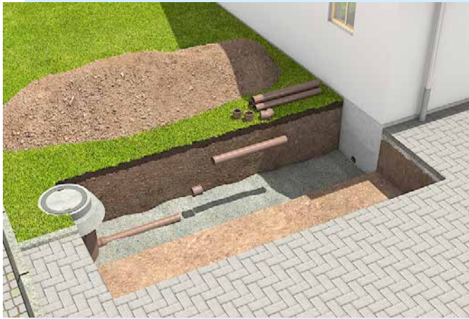
Erneuerung in offener Bauweise
